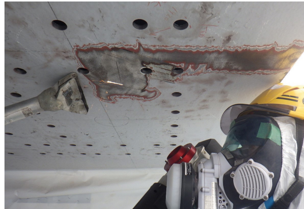
JPL工法®による塗膜除去と素地調整状況
