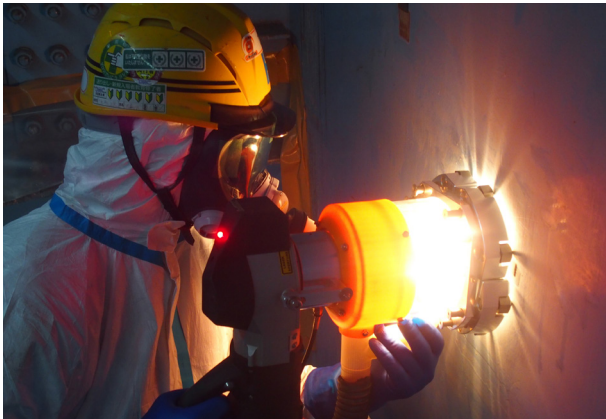
JPL工法®による塗膜除去
