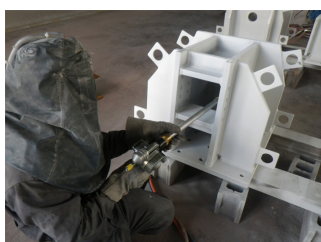
専用の溶射ノズルによる狭隘部への施工状況
