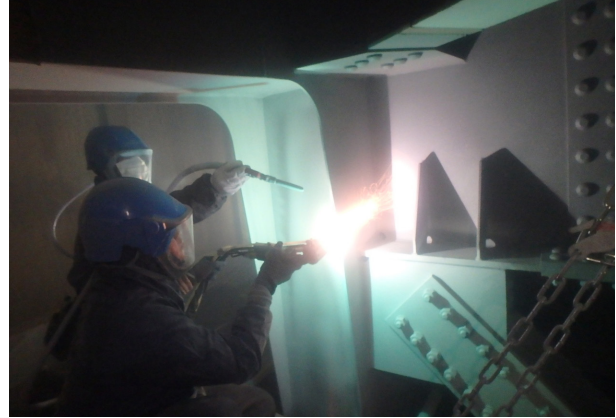
プラズマアーク溶射（TAPS） 施工状況
