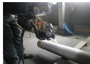
柱への施工状況
