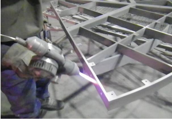
ガス溶射 施工状況
