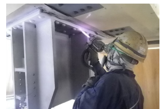
落橋防止装置への施工状況
