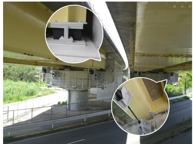
高速道路 支承・落橋防止装置（アルミ・マグネシウム合金）
