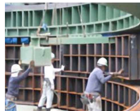
鋼製部材 部材が小型軽量であり、任意の径で施工可能。
