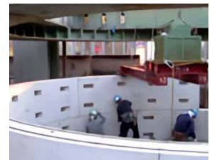
RC製部材 直接本体利用できるため急速施工が可能。
