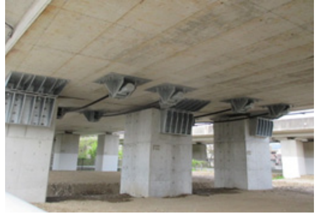
高架橋の落橋防止装置の採用例
