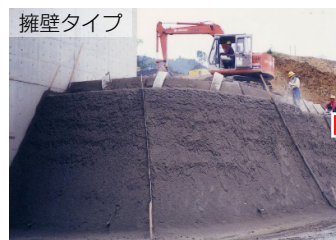
施工中 (長繊維混入補強土吹付工)
