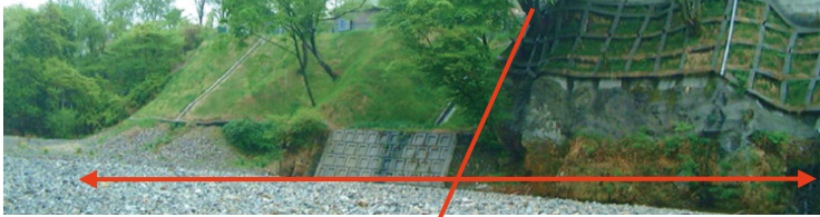
ローピングウォールⅡ工法 (法面保護タイプ)
