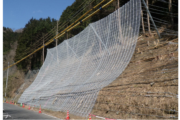
施工事例 (KB-RS5.0)
