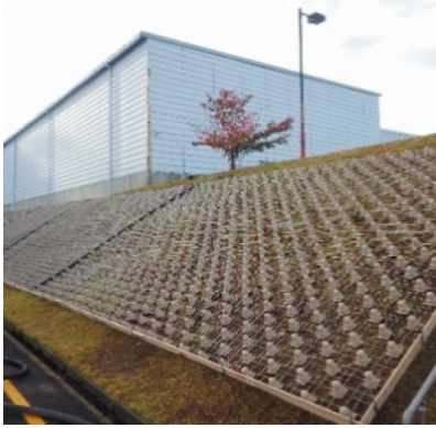
パルプモールド設置工
