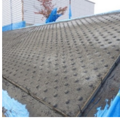
基面部吹付工
