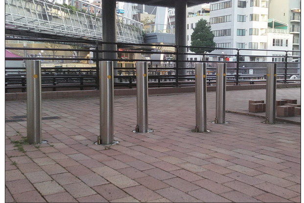
JN-11施工写真
