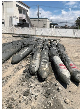
本工法で引き抜かれた杭 (先端にも損傷などはない)
