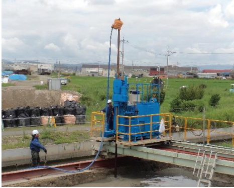
ESJ工法 施工状況
