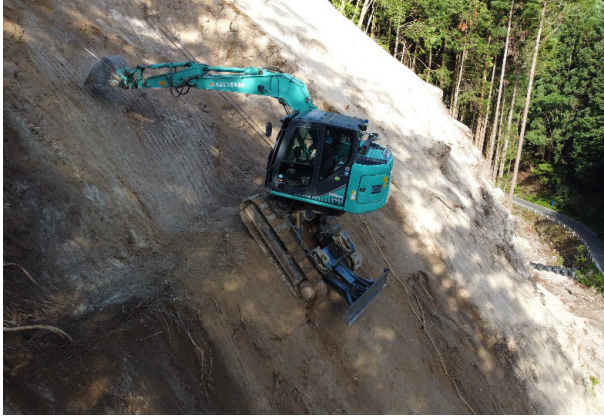
急傾斜地での掘削状況①
