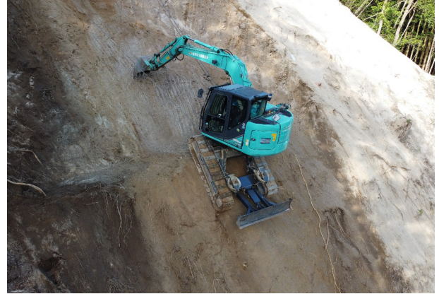
急傾斜地での掘削状況②
