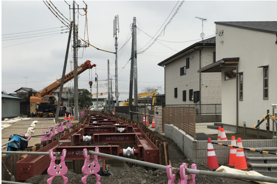
構造物際での施工
