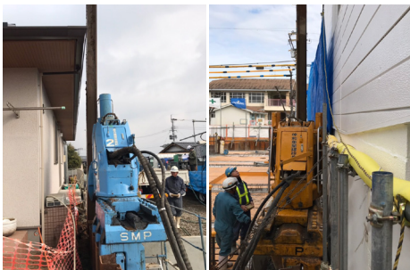
民家際での近接施工
