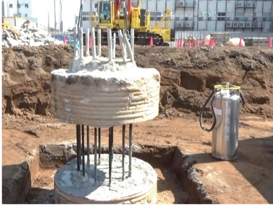
杭頭処理工法「しずかちゃん®」の施工
