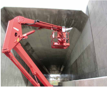
噴霧器による施工状況
