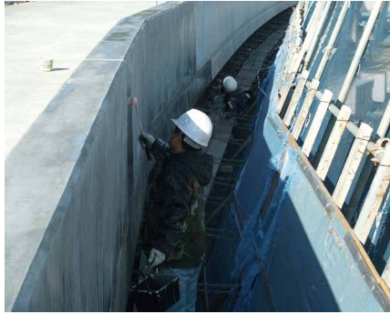
ローラー刷毛による施工状況
