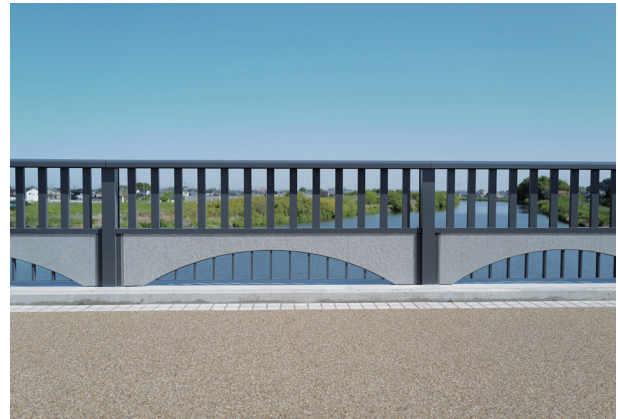
施工例（高欄パネル）
