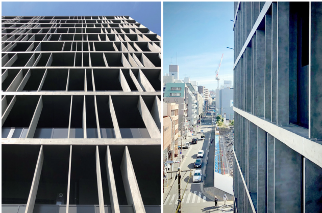
施工例（集合住宅のルーバー（日よけ））
