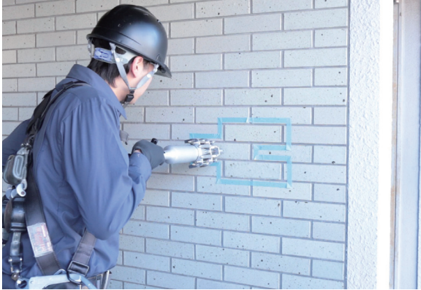
Jfp工法 施工例（樹脂注入状況）
