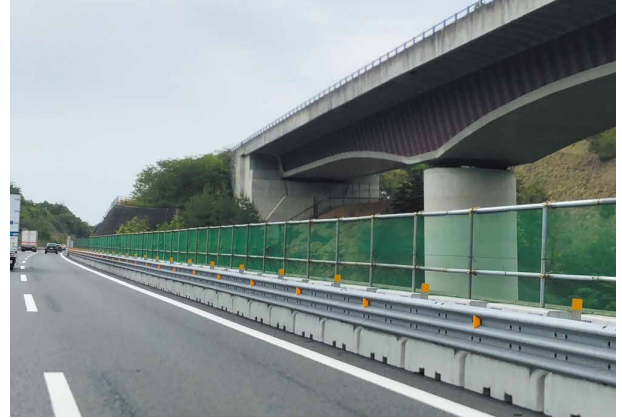
GUブロックSB種/新名神高速道路 信楽工事
