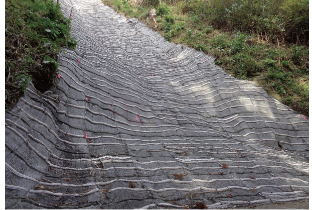
施工例 (モルタル袋が等高線状の小段を形成)
