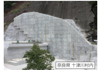
既設擁壁補強・上部構造物改修
