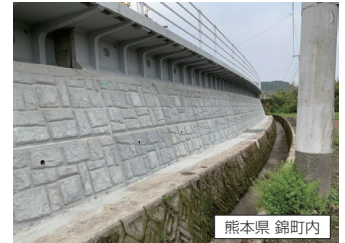
既設擁壁補強・上部構造物改修
