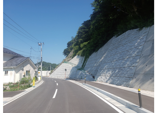
道路の山側切土拡幅例 (岩手県宮古市内)
