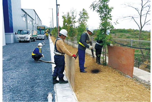
吹付工法の施工状況
