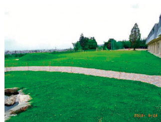
茨城県 小学校整備工事
