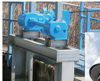
減速駆動装置（水門開閉）
