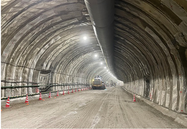
懸垂型での施工例
