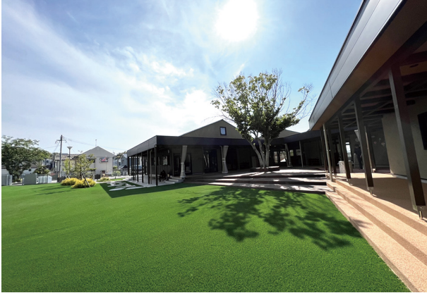
施工事例（保育園）
