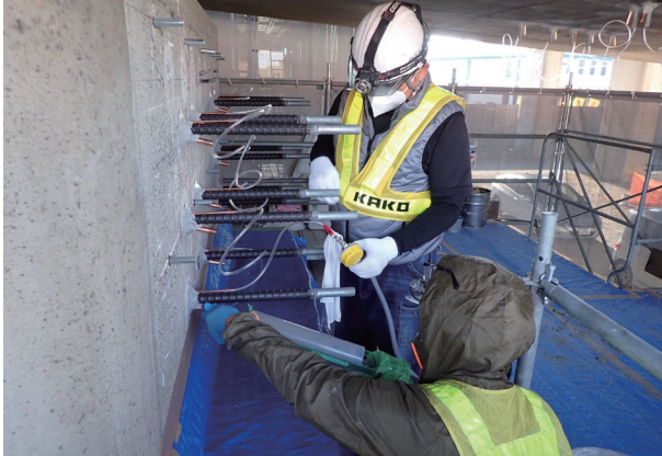
グラウト材注入状況
