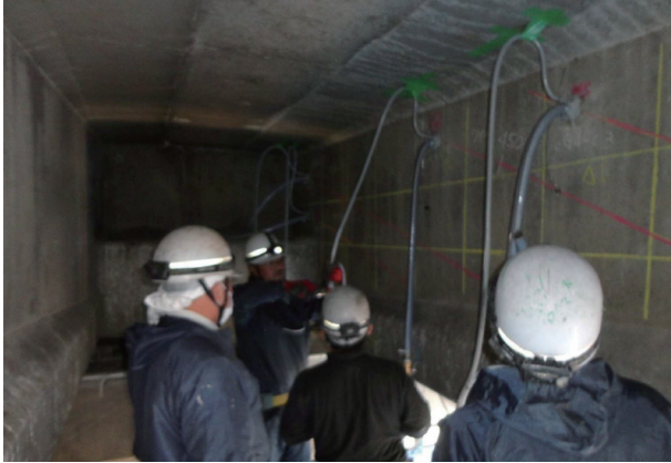
既設桁への再注入状況
