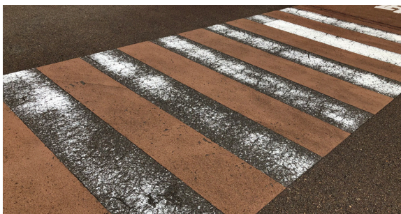
K-グランドコート経年状況 白線よりも耐摩耗性が高い
