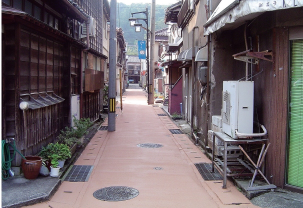
施工例 山中温泉地内コミュニティ道路
