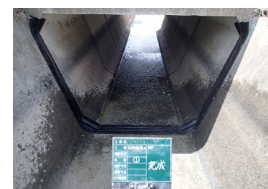
大型VトラフとVボックスの接続（由仁町） 由仁土地改良区
