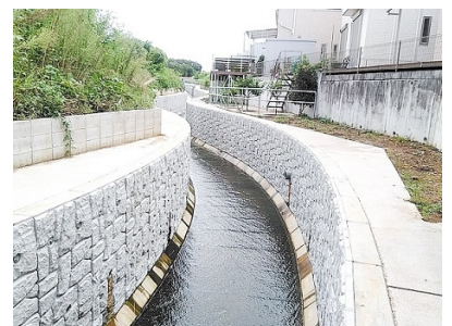
曲線施工箇所
