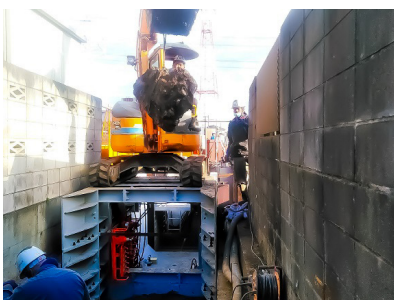
狭隘部施工（NOS III型）
