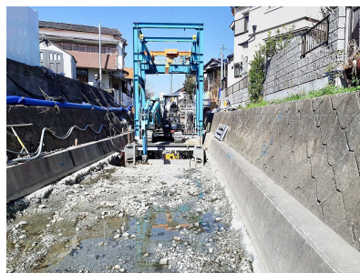
河床下新設（函体吊下ろし設備設置）
