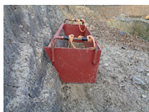
混合土投入用型枠
