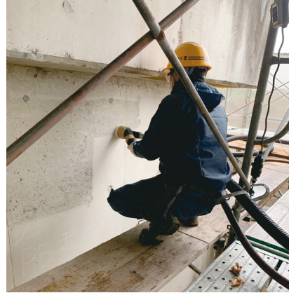
コンクリート橋脚 補強下地処理
