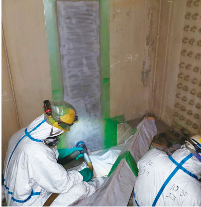
鋼橋塗り替え工事の素地調整
