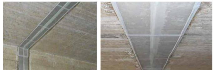
パッチシールクロス®の表面から内部のクラドリップ®と空間の土砂の堆積・滞水の状態を確認できる
