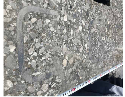
コンクリート床版/馬蹄ジベル 切断後の状況
