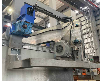
試験施工の様子
