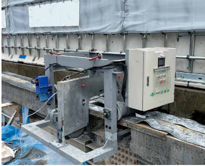
現場切断施工の状況
