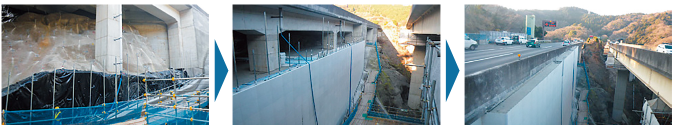
橋脚や橋桁を残したまま、気泡混合軽量土によって土工化。メンテナンス費用を低減し、橋梁の長寿命化に貢献する。
