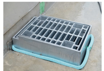
コンクリート床版への設置完了
