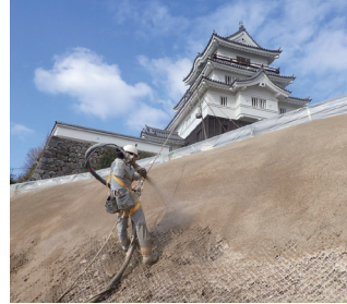
〈景観に配慮した公園整備〉 自然斜面 防草土吹付
