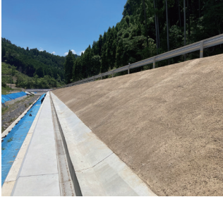
〈盛土面 防草対策〉 防草土吹付 (現地発生土利用)
