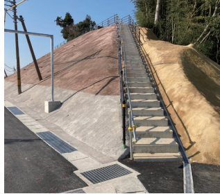
〈切土面 法面保護工〉 景観に配慮した着色吹付
