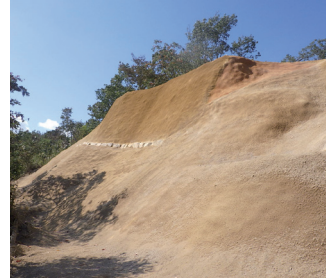
〈史跡保存整備〉 自然色および着色吹付
