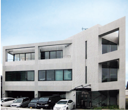
タフレジッククリアガードHD工法 施工例
