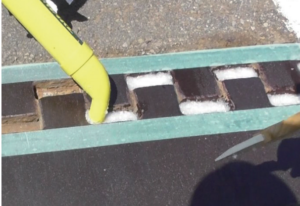
橋梁伸縮装置への樹脂充填状況
