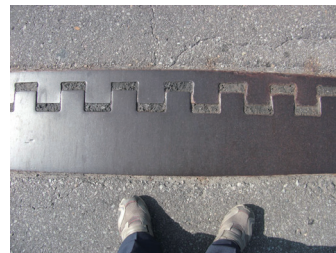
大船川橋施工1年後点検 (変状は見られない)
