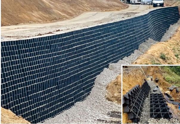
小型・軽量の高密度ポリエチレン製「ジオセル」を用いた擁壁工法（GEOハイウォール工法）
