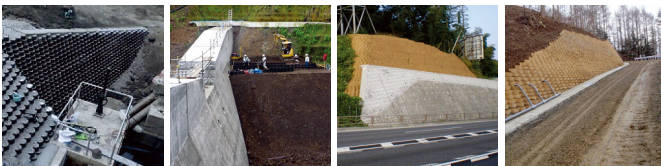
堤体工事（千葉都） 砂防工事（東京） 法面修復工事（神奈川） 道路擁壁工事（長野）
