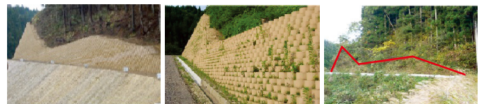
施工完了時 一年後 10年後
