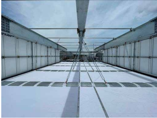
新設計のパネル式を採用しているので、 広くて使いやすい新しいシステムつり足場
