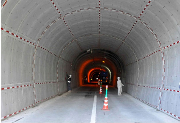
トンネル内面補強 (R=3.34m)
