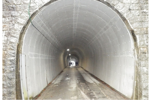
トンネル内面補強 (R=2.0m)
