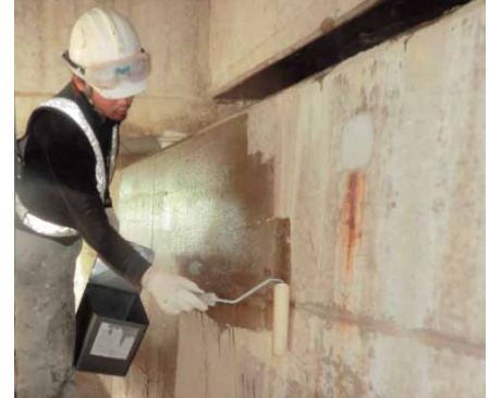
放射状に含浸して均等な吸水防止層を形成するため、多少の塗りムラは気にする必要がない
