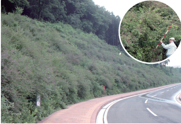
斜面樹林化工法 (施工2年4カ月後)
