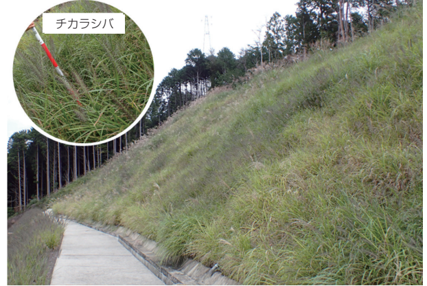
原風景緑化工法 (施工1年10カ月後)
