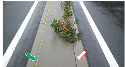
比較施工写真 施工後約1年経過 平成20年6月撮影
