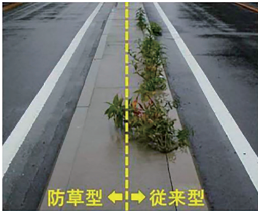
平成20年6月 (施工後1年経過)
