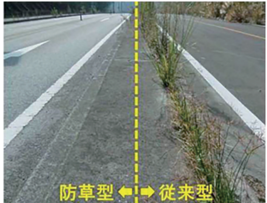
平成27年11月 (施工後8年5カ月経過)
