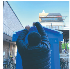
③屋根パネルを取り付ける
