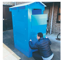
④扉を取り付け、耐風ローブにて防風対策を行い完成
