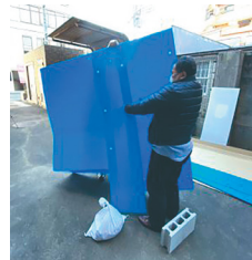
①背面パネルと側面パネルを、コーナーパネルを返しジョイントする
