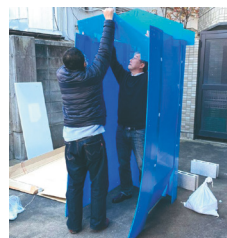
②三角屋根下地3枚を取り付ける
