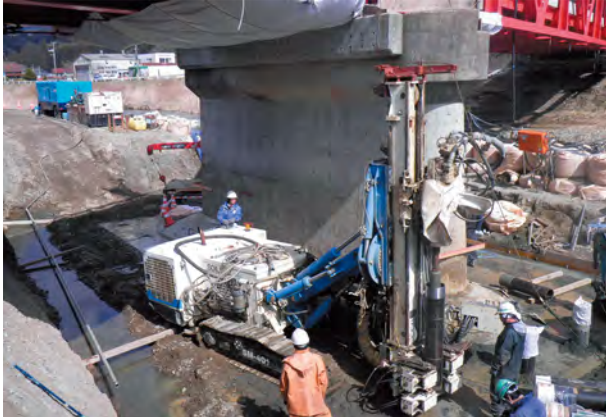
既設道路橋耐震補強杭（直杭）
