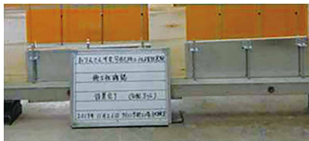
可変勾配状況
