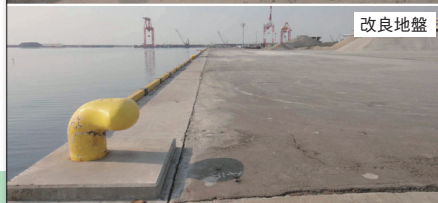
仙台塩釜港液状化対策工事（2011.4.27撮影）
