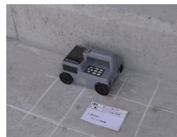
①鉄筋探査工 (RC レーダー探査)
