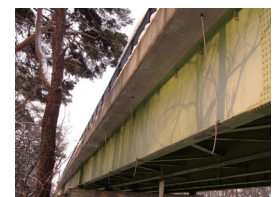
⑥完成 (パイプ下部にはフレキシ ブルチューブで流末接続)
