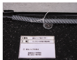
⑤導水パイプの係止 (中間部の連続係止および 末端部の挿入係止)
