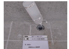
④充填工 (樹脂系および無機系)
