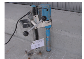
②コンクリートコア削孔工 (≒φ52×床版)
