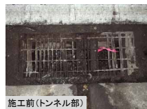
施工前(トンネル部)
