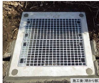
施工後(明かり部)
