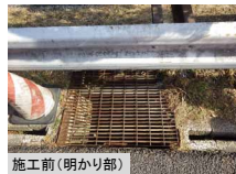
施工前(明かり部)
