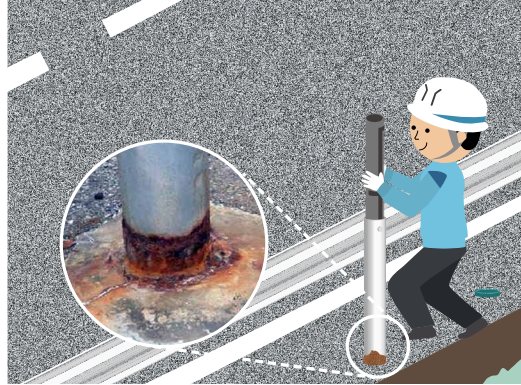
錆が極度に進行した状態でも、健全な支柱と同等の強さに補強 (1箇所当たり約5分で施工完了)
